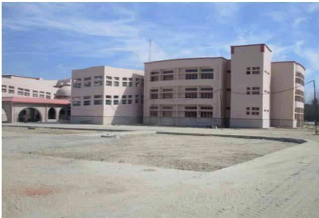
के.वि. गज्ज (भुंगा) का नव निर्मित भवन Newly constructed building of K.V. Gajj (Bhunga)
