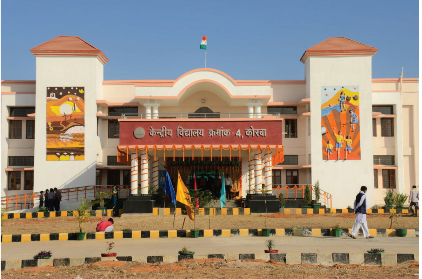
केन्द्रीय विद्यालय क्रं. 4, कोरबा, छत्तीसगढ़ का नवनिर्मित भवन Newly constructed building of KV No. 4, Korba, Chhattisgarh
